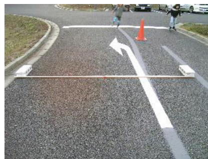
図 6 実験コース内に設置された段差区間(B 地点)
